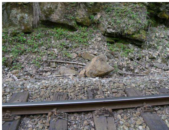
Foto 34-3 v minulosti odvalený blok uvízlý v akumulacním prostoru, který je nutné udržovat.
