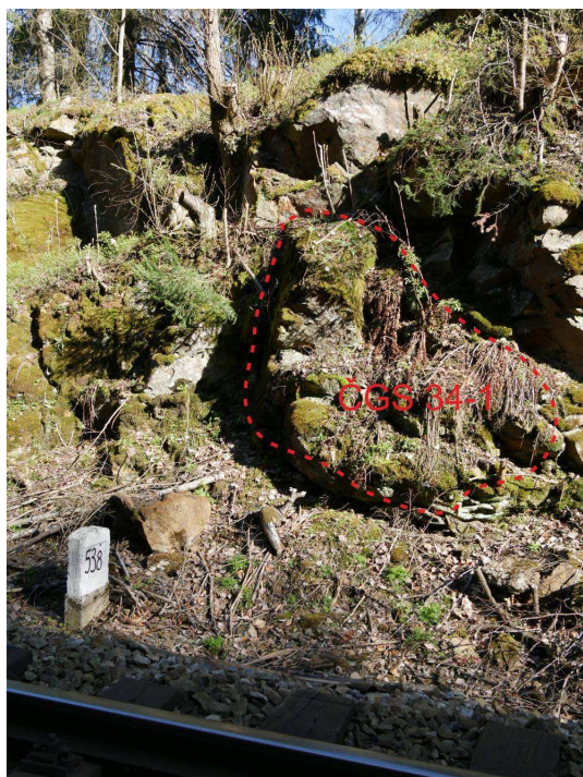
Foto 34-1 červeně označený potenciálně nestabilní blok v km cca 53,800.
