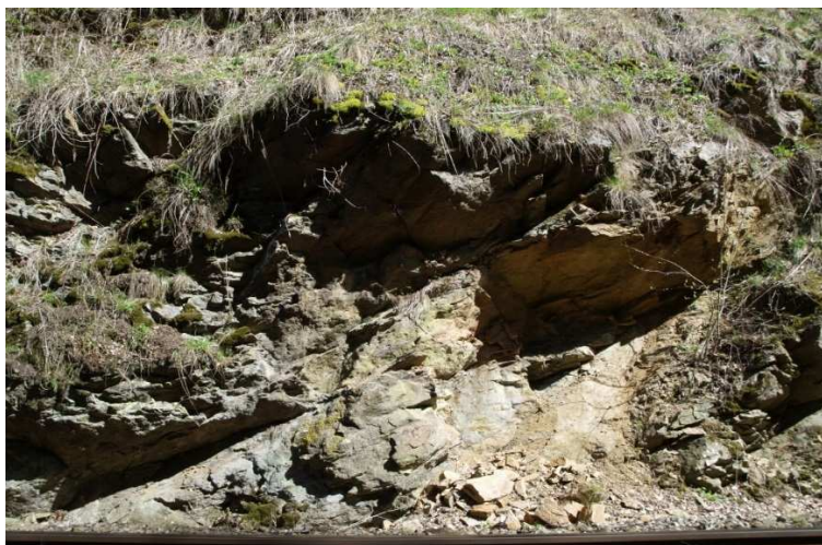
Foto 24-2 Bližší pohled na skalní převis (viz foto 24-1), pohled z nárysu. Blok je vhodné vizuálně monitorovat, jestli nedošlo ke změně stavu aktivity vlivem zvětrávacích procesů nebo narušení stability, např. kořenovým systémem náletu.
