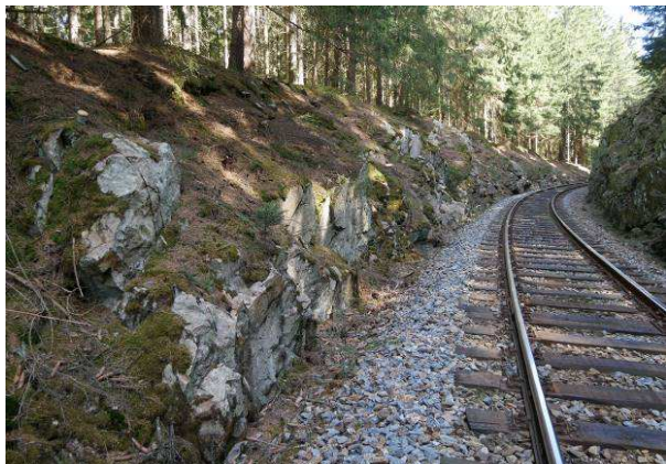
Foto 30-1 Fotografie dokumentující vzdálenost (1,5 m) a výšku (do 3 m) zájmové skalní stěny od železniční trati.
