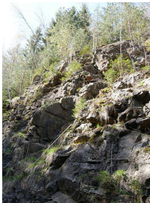
Foto 31-7 Příklad rozvolněné rizikové horní partie stěny hustě pokryté náletovou vegetací (cca km 53,360).
