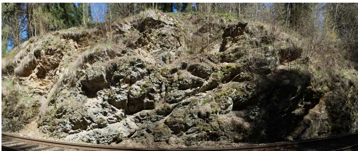
Foto 24-4 Ve zbytku terénního zářezu nedochází k významnějším projevům svahového pohybu. Riziko lze snižovat běžnou údržbou průběžným odstraňováním náletu.
