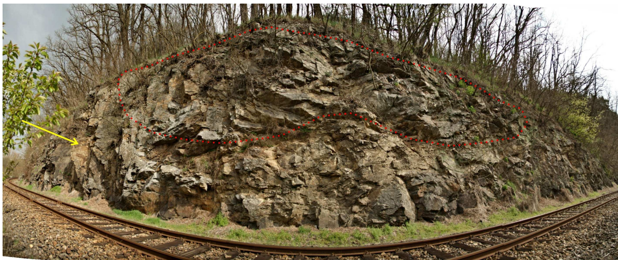
Foto 4-1 Charakter skalního zářezu v okolí cca km 7,838. Červený tečkovaný polygon zvýrazňuje horní část s mnoha převisy s uchycenými náletovými dřevinami. Žlutá šipka vlevo ukazuje na partii s typickým křehkým porušením masivu a jím vyčleněné nestabilní skalní objekty (skalní klíny; foto 4-2).
