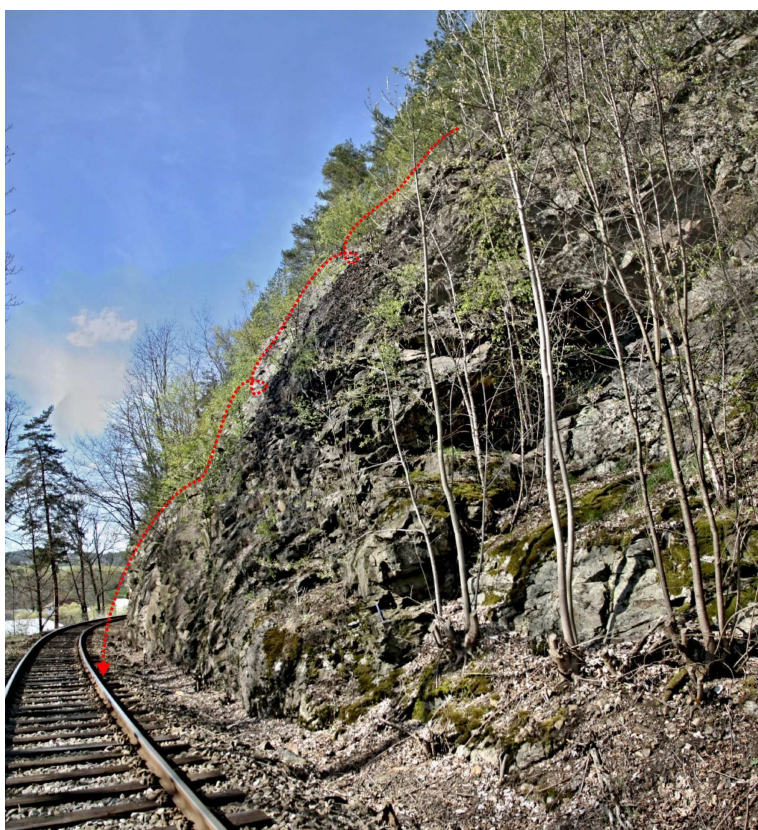
Foto 13-9 Červená křivka naznačuje možnou trajektorii pohybu řícených hmot s potenciálem zasáhnout ohrožený prostor kolejíště v části cca km 24,787–24,840.
