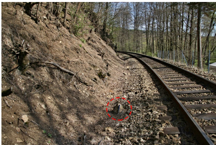
Foto 13-5 Příklad odvaleného skalního objektu o velikosti 2–4 dm 3 v části cca km 24, 700–24,733.
