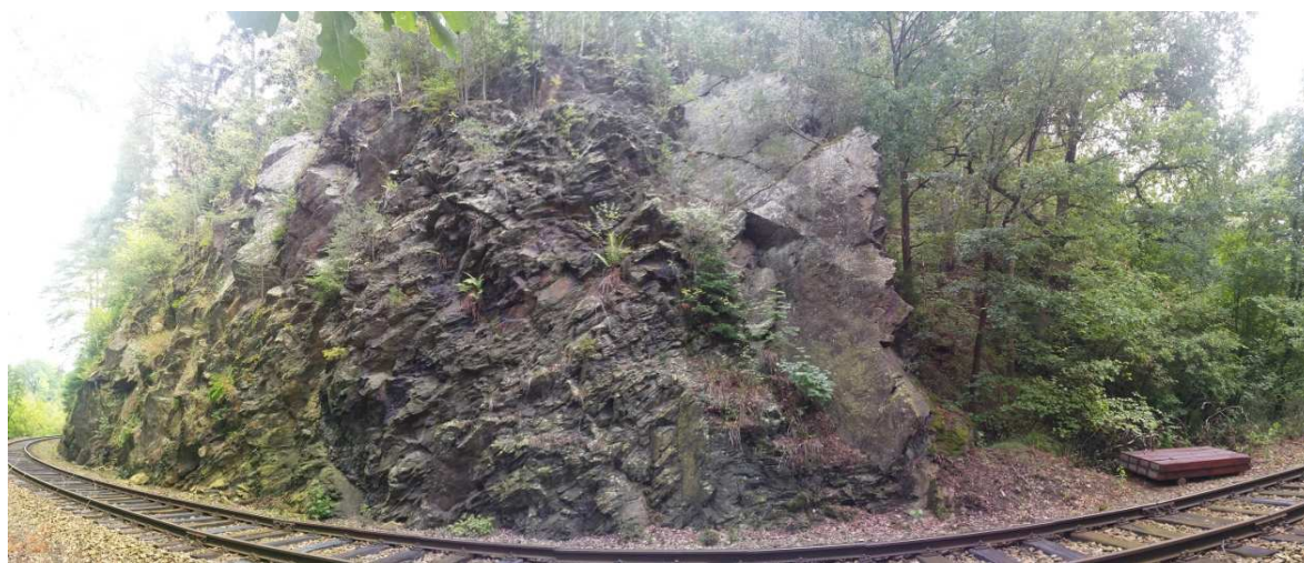
Foto 16-3 Celkový pohled na posuzovaný zářez část 2. Ve stěně jsou nesouvisle uchyceny náletové dřeviny, které masiv rozrušují. Dále je patrný výrazný subvertikální puklinový systém, uklánějící se směrem po svahu.
