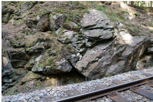
Foto 30-4 Poměrně kompaktní skalní stěna, u níž postačí k udržení rizika na přijatelné úrovni, pravidelná údržba.
