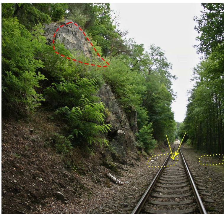
Foto 18-3 Pohled ze strany ve směru staničení. Červený čárkovaný polygon zvýrazňuje zdrojovou oblast. Tečkovaný polygon zasahující do kolejiště zvýrazňuje dokumentované skalní úlomky, které byly transportovány až do prostoru kolejiště, jak naznačují šipky. Tečkovaný polygon vpravo zvýrazňuje odklizenou akumulaci proběhnuvšího řízení v minulosti.
