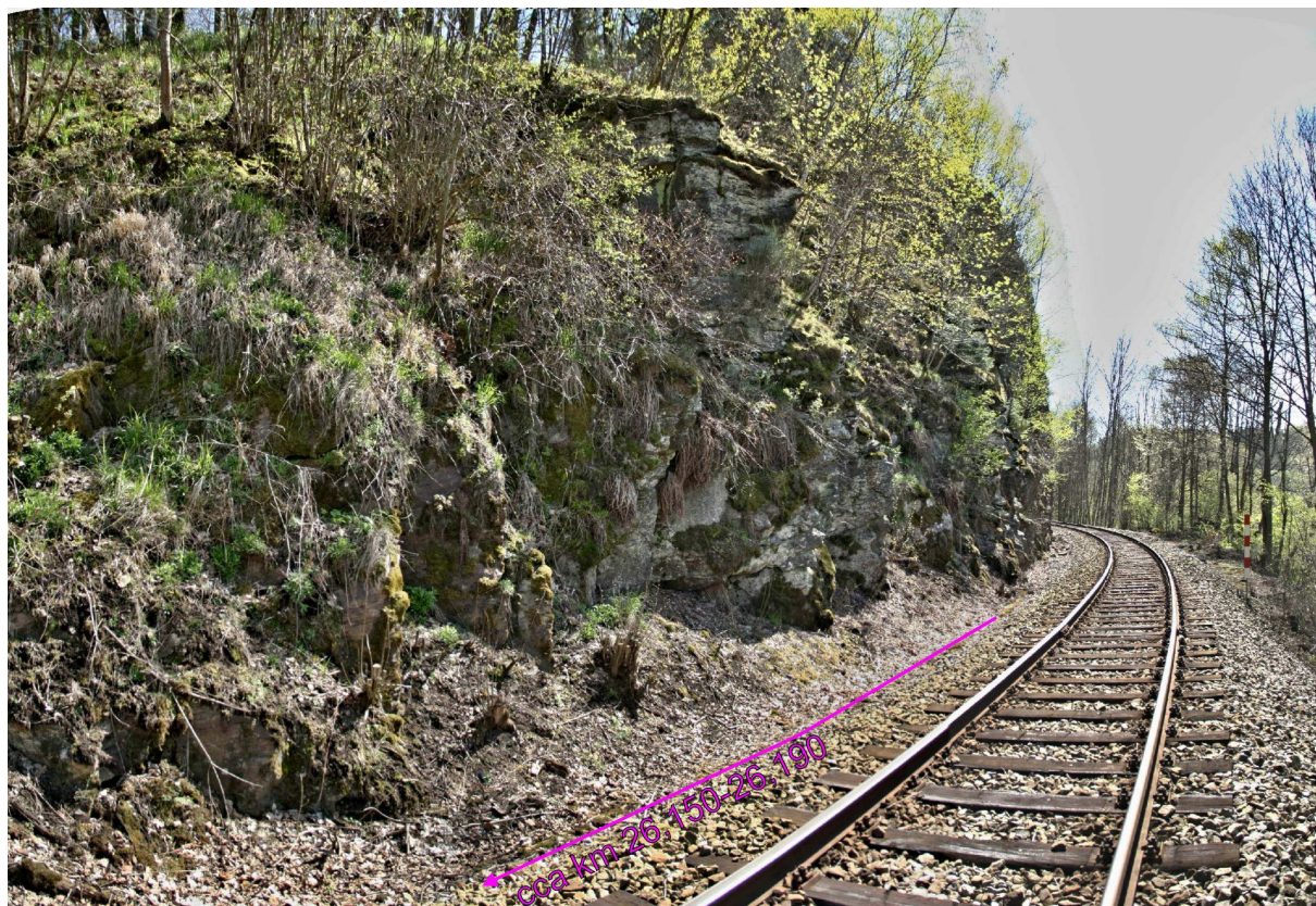
Foto 15-2 Část skalního zářezu okolo cca km 26,150–26,190. Odstup skalní stěny od kolejiště a charakter svahového pohybu sesypáním neumožňuje transport až do prostoru kolejiště.
