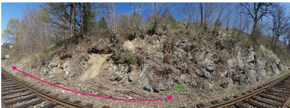
Foto 20-4 Část nejvíce náchylná k svahovému pohybu se nachází v úseku km 31,220–31,235 (fialová křivka).
