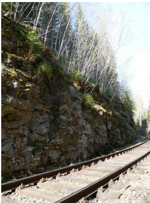
Foto 33-6 Příklad části 53,760–53,900 ukazující velmi prudký a zalesněný svah nad zářezem představující riziko pro provoz železnice.
