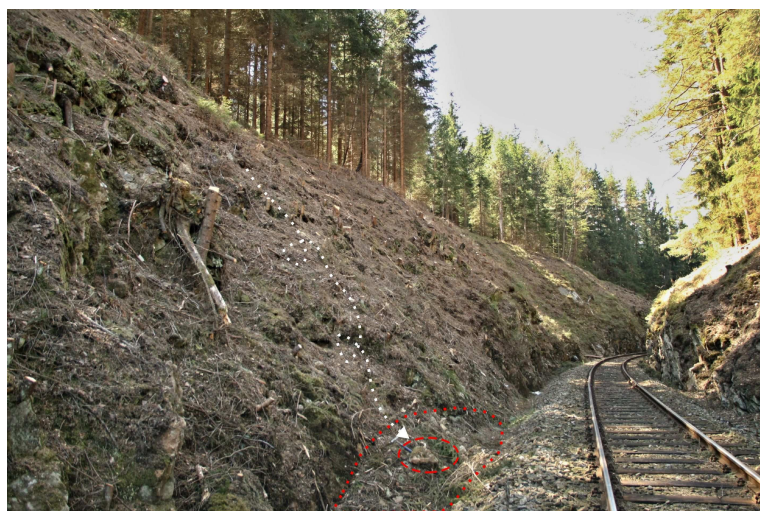
Foto 21-1 Příklad aktivních projevů svahového pohybu sesypáváním s následným odvalováním po povrchu svahu na cca km 36,316. Bílá tečkovaná linie naznačuje trajektorii pohybu při odvalování. Červený tečkovaný polygon pak ohraničuje akumulaci osypového kužele.
