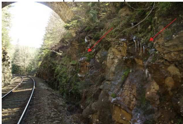
Foto 23-1 Diskontinuitami porušení poměrně výrazně prosakuje voda. Zároveň je dobře patrné, že v úsecích se skalními výchozy v okolí cca km 36,600 až 36,680 nedochází k projevu svahového pohybu.
