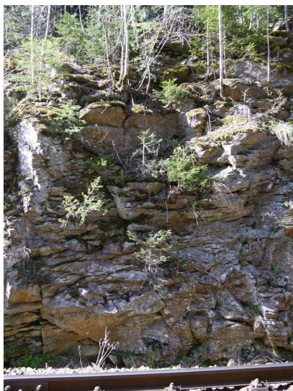
Foto 33-5 Část úseku v cca km 53,760 velice porušená křehkými diskontinuitami a pokrytá náletovými dřevinami.
