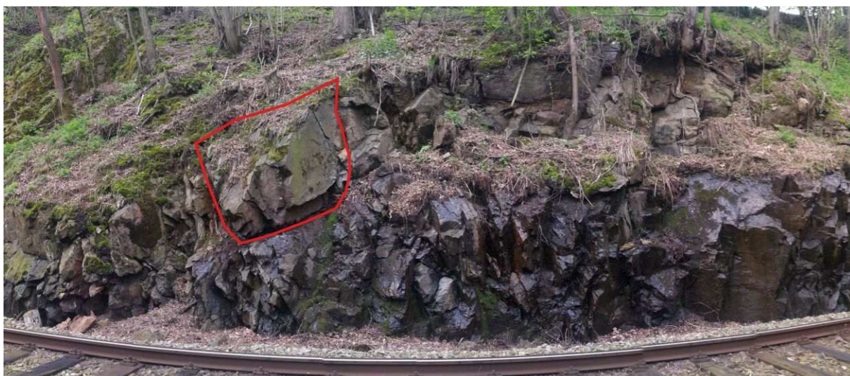
Foto 1-3 Příklad poruchové zóny na cca km 4,360, kde se nachází skalní blok o velikosti větší než 1 \text{ m}^3 .
