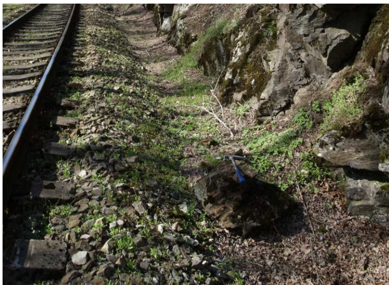
Foto 14-4 Při úpatí zářezu lze nalézt drobné osypy a jednotlivé skalní objekty o maximálních rozměrech několika dm 3 .
