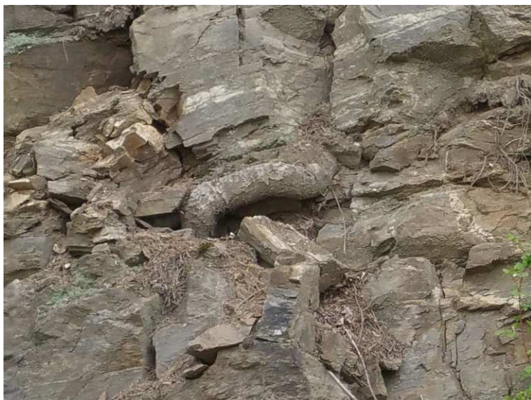
Foto 3-2 Detail skalního zářezu v okolí cca km 7,500. Zřetelně lze vidět kořenový systém, který postupně působí na masív dezintegračně. Masív je výrazně postižen křehkou tektonikou, což dále snižuje jeho stabilitu.
