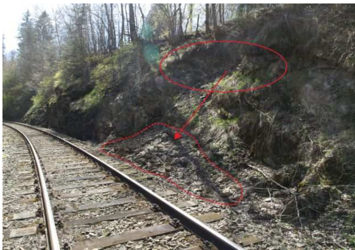
Foto 23-2 Příklad aktivních projevů svahového pohybu sesypávání. Elipsa označuje zdrojovou oblast sesypaných drobných úlomků skalního masivu. Šipka znázorňuje přibližnou trajektorii pohybu. Tečkovaný polygon pak ohraničuje akumulaci ospyvého kužele.
