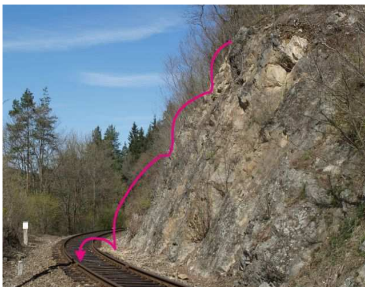
Foto 19-5 Riziková jest také samotná konfigurace svahu a úpatí, kdy se mohou říčené hmoty akumulovat nejen u paty svahu před náspem železničního tělesa, ale transportovat také přímo do prostoru drážního tělesa.
