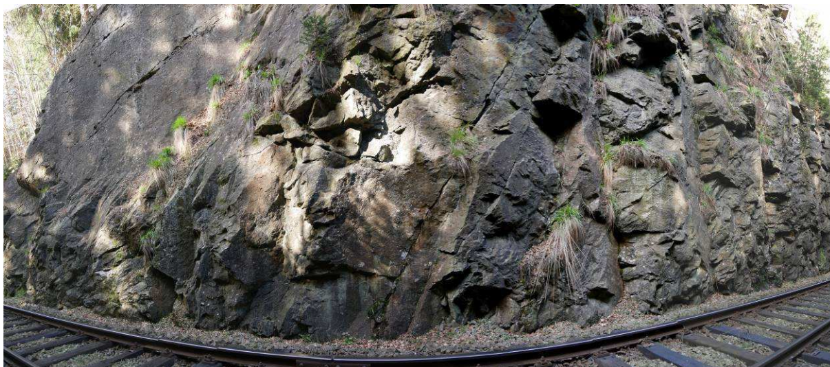
Foto 31-1 Spodní partie úseku jeví se relativně kompaktně bez viditelně oddělených bloků od masivu.
