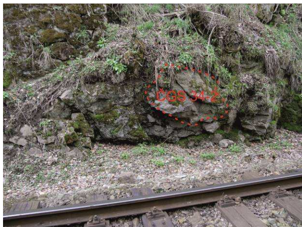
Foto 34-2 červeně označený potenciálně nestabilní blok v km cca 53,765.
