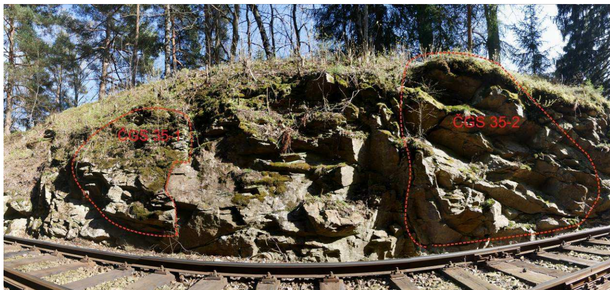
Foto 35-1 Nejaktivnější části v cca km 61,590–61,605 s červeně vyznačenými partiemi ČGS 35-1 a 35-2.
