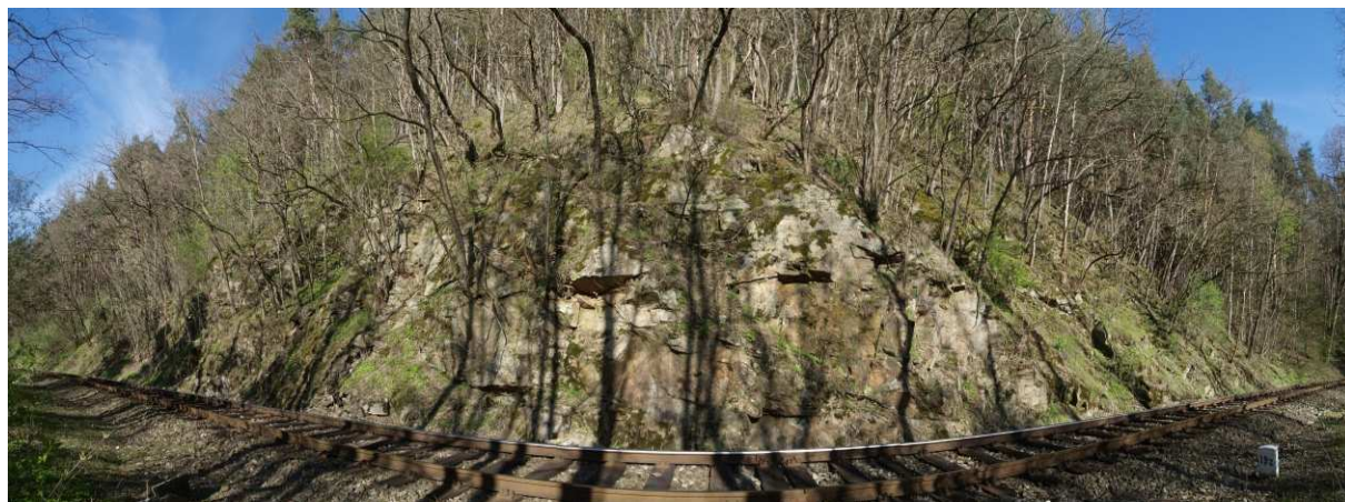
Foto 11-1 Celkový pohled na posuzovaný skalní svah. Dobře jsou vidět vyvinuté skalní převisy, ze kterých se průběžně uvolňují skalní bloky nejčastěji o velikosti do 1 m 3 . Střední část skalního svahu je nejvíce náchylná k svahovému pohybu.
