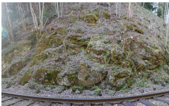
Foto 33-8 Cca km 53,890 masiv porušený diskontinuitami s filtrující vodou.
