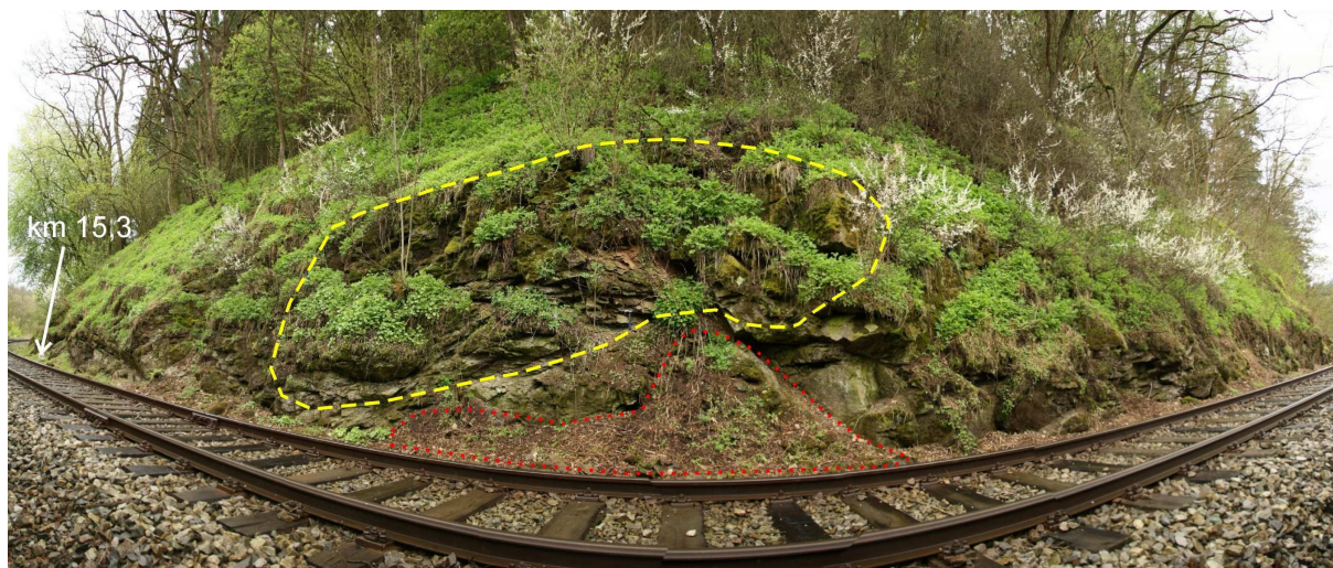
Foto 7-5 Panoramatický pohled na zářez v okolí cca km 15,323. Žlutý polygon ohraničuje značně rozvolněnou partii. Tečkovaný červený polygon zvýrazňuje osypový kužel při úpatí zářezu.
