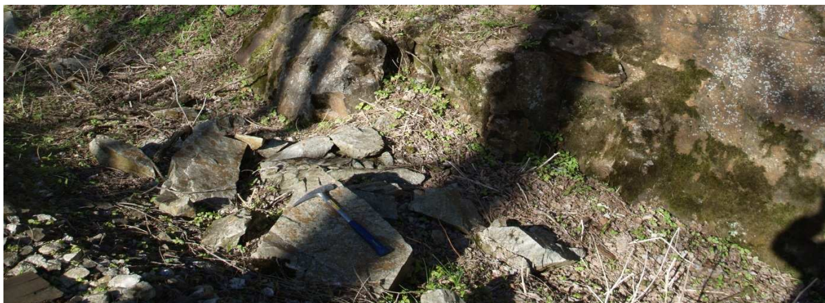
Foto 11-2 Akumulace uvolněných skalních objektů o velikosti nejčastěji několika \text{dm}^3 při patě zářezu.
