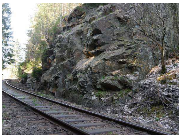
Foto 36-4 Poměrně kompaktní a celistvá spodní část skalní stěny v úseku km 61,550-61,660.
