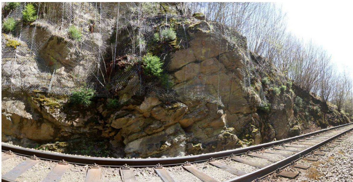
Foto 26-1 zasít'ovaná partie cca km 37,115–37,135 kde ČGS doporučuje revizi stávajících sanačních prvků.
