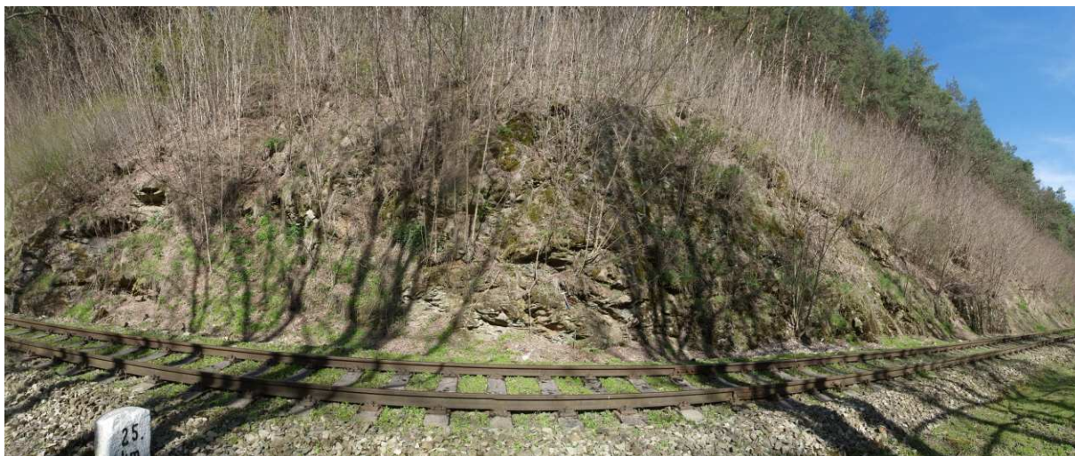
Foto 14-2 Celkový pohled na rekognoskovaný masiv. Lze vidět, že masiv je v celém posuzovaném úseku porostlý náletovými dřevinami, které ho rozrušují.
