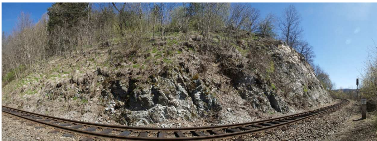
Foto 19-6 Celkový pohled na posuzovaný skalní svah. Ve střední části snímku je patrné intenzivní křehké porušení horniny. Masiv je porušen dvěma dominantními subvertikálními systémy puklin.
