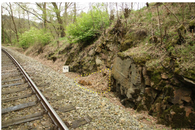
Foto 2-4 Pohled ze strany na ospový kužel na cca km 4,398 (viz foto 2-3). Sesypané skalní úlomky se akumulují vedle železničního tělesa.
