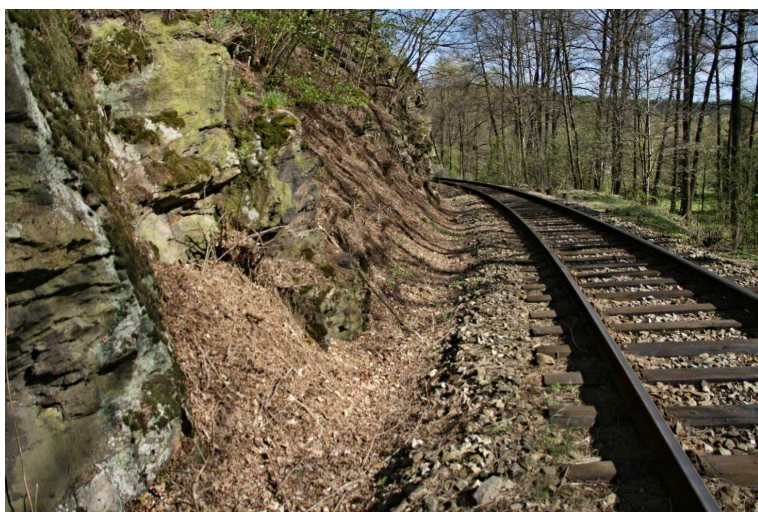
Foto 13-7 V části cca km 24,733–24,787 je odstup kolejiště od paty svahu minimální.
