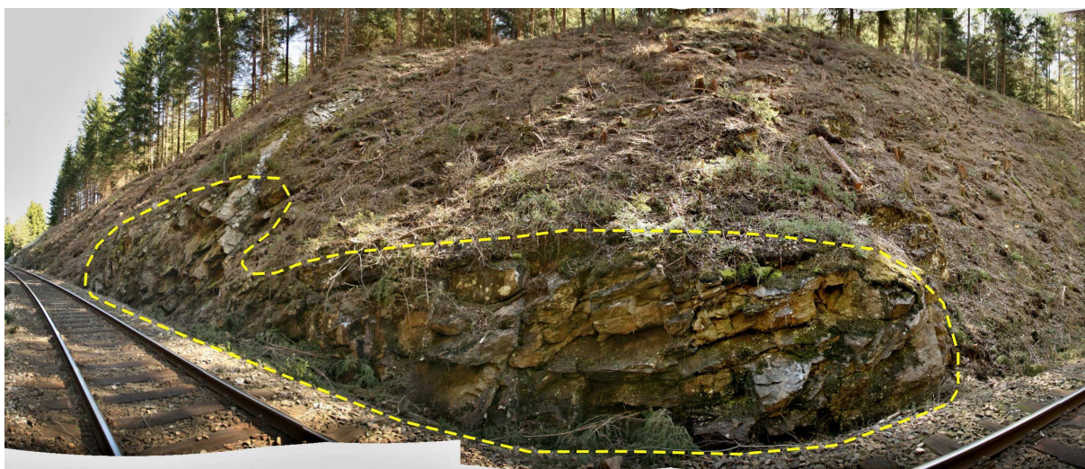
Foto 21-3 Skalní výchozy v okolí cca km 36,378. Nízký gravitační potenciál svahu a vyvýšený násep železničního tělesa, před kterým se nachází akumulací prostor, omezuje transport sesypaných skalních objektů do prostoru kolejiště.
