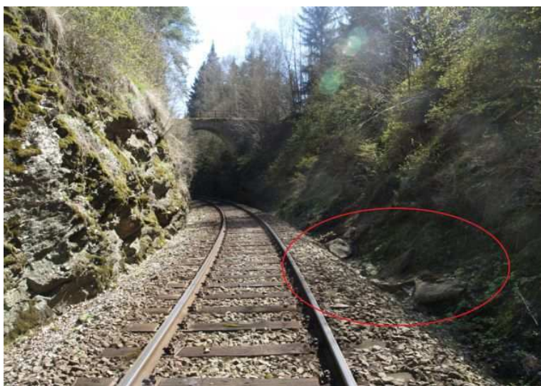
Foto 23-4 Díky konfiguraci svahu a úpatí se budou říčené hmoty akumulovat hned u paty svahu před náspem železničního tělesa.
