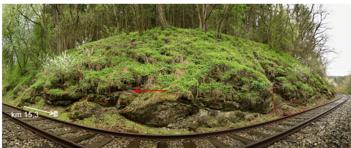
Foto 7-3 Panoramatický pohled v okolí cca km 15,310. Tečkované polygony ohraničují osypové kužely při úpatí zářezu. Červená šipka uprostřed ukazuje na porušenou a zvětralou partii.
