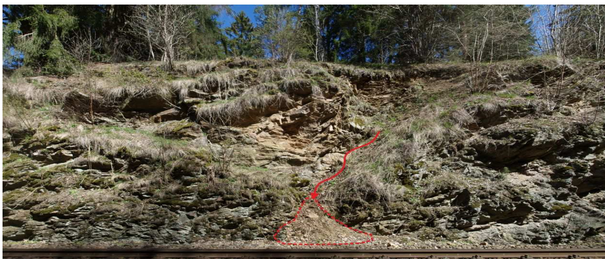
Foto 24-3 Ve zbytku zářezu nedochází k významnějším projevům svahového pohybu, pouze se vytvářejí drobné ospové kužele (čárkovaný polygon).
