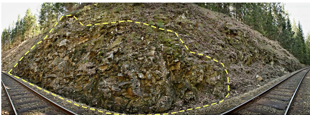
Foto 21-4 Skalní výchozy v okolí cca km 36,390 Gravitační potenciál svahu a vyvýšený násep železničního tělesa, před kterým se nachází akumulací prostor, neumožňuje transport do prostoru kolejiště.
