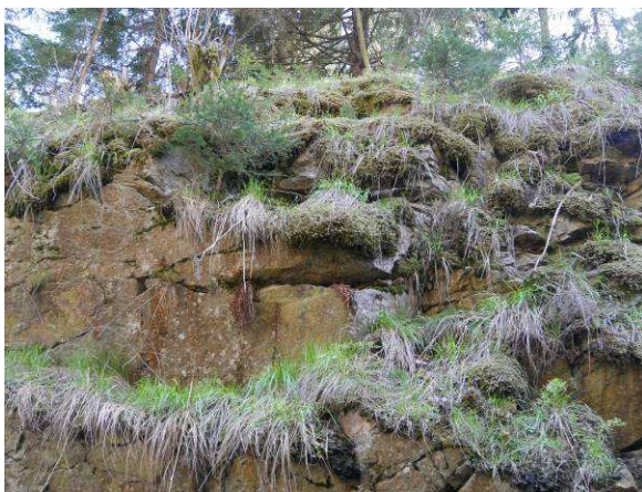
Foto 32-8 Příklad rozvolněné horní partie zářezu pokrytá náletovou vegetací.
