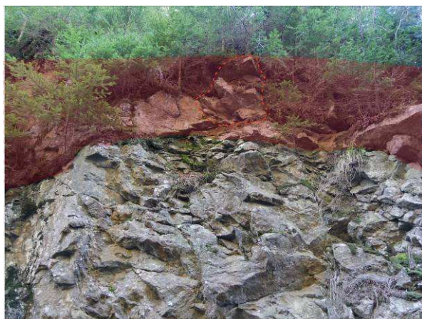
Foto 32-5 Část úseku v cca km 53,400 s červeně vyznačenou rizikovou horní partií zářezu a jedním potenciálně rizikovým blokem červená čára.
