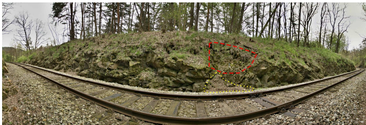
Foto 2-2 Příklad poruchové zóny na cca km 4,363, kde dochází k sesypávání skalních úlomků. Červený čárkovaný polygon zvýrazňuje zdrojovou oblast, žlutý tečkovaný kopíruje akumulaci osypového kužele.
