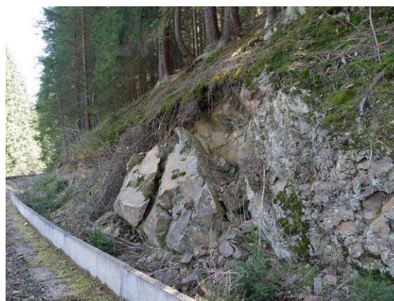
Foto 27-3 Dokumentovaný odvalený skalní blok o objemu cca 6 m 3 doporučený k odstranění (km cca 38,889).
