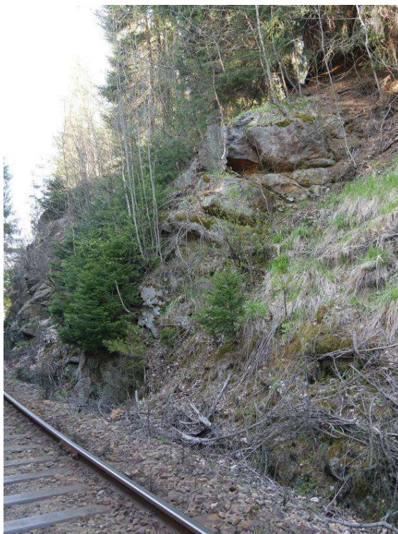
Foto 36-7 Konec nerizikovější partie v km cca 61,660 porušený systémem diskontinuit a pokryt náletovou vegetací.
