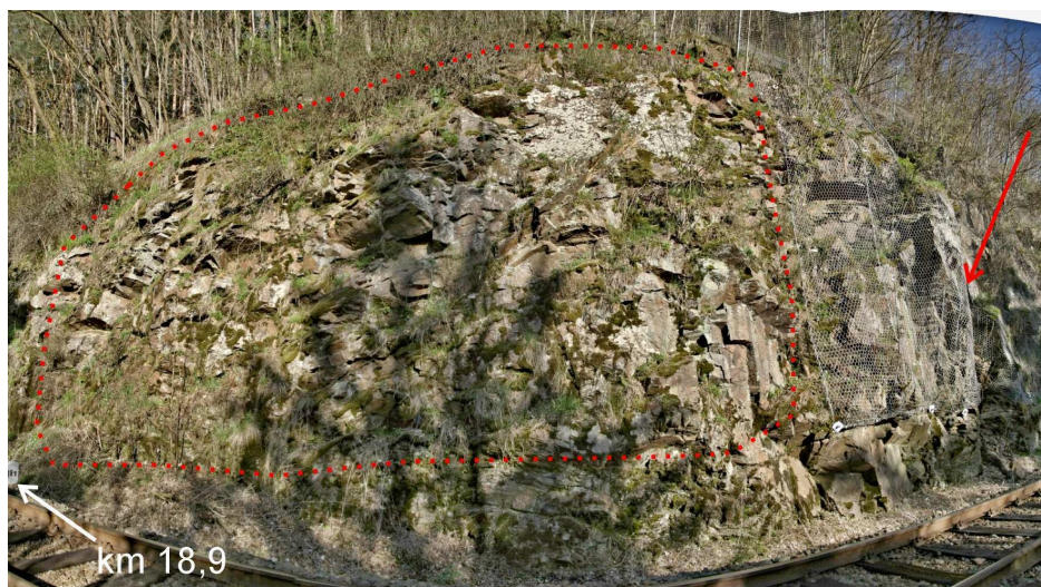
Foto 9-3 Nezajištěná část zářezu s výškou vyšší, než 3 m na cca km 18,883–18,915 (viz foto 9-1). Zářez je zde méně členitý, než navazující zajištěná část cca km 18,915–18,965. Šipka vpravo ukazuje na místo řícení za stabilizační ocelovou hřebíkovanou sítí (viz foto 9-4). Šipka vlevo ukazuje na kilometrovník tratě.
