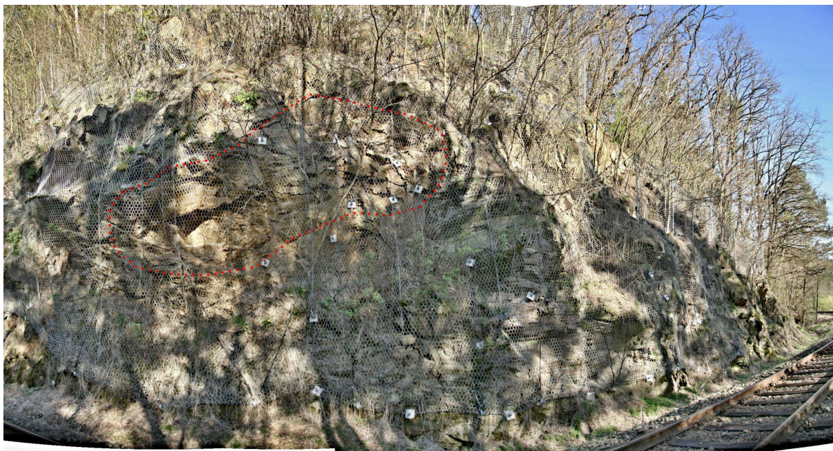
Foto 9-5 Sesypání až odvalení sklouznutím skalních úlomků za stabilizačními prvky na cca km 18,930. Ocelová síť plní stále svoji funkci.
