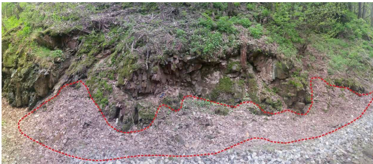
Foto 1-2 Skalní stěna zářezu má potenciál k projevu svahového pohybu zejména sesypáváním o objemu sutě do 1 \text{ m}^3 . Lokálně jsou patrné také nepříliš mocné osypové kužele.
