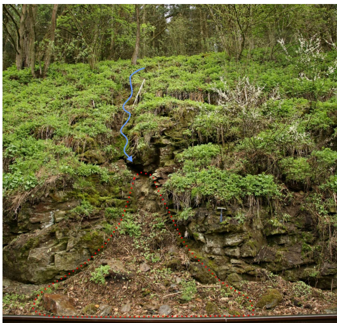
Foto 7-3 Panoramatický pohled v okolí cca km 15,310. Tečkované polygony ohraničují osypové kužely při úpatí zářezu. Červená šipka uprostřed ukazuje na porušenou a zvětralou partii.
