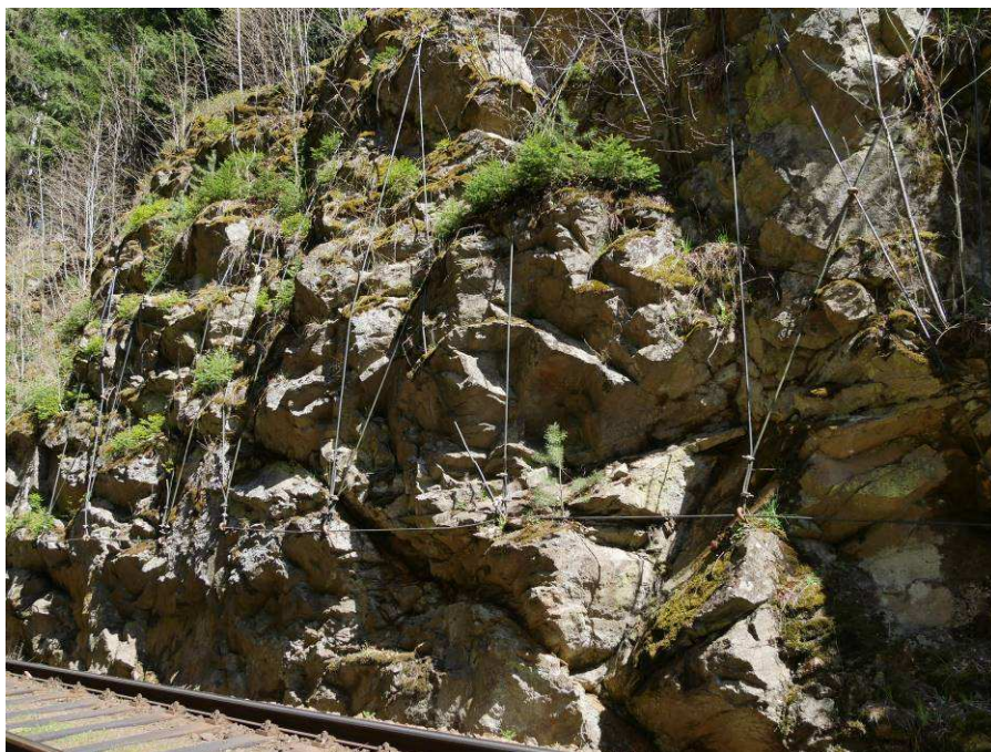
Foto 26-4 cca km 37,145–37,165 sanace kotvenou převázkou.
