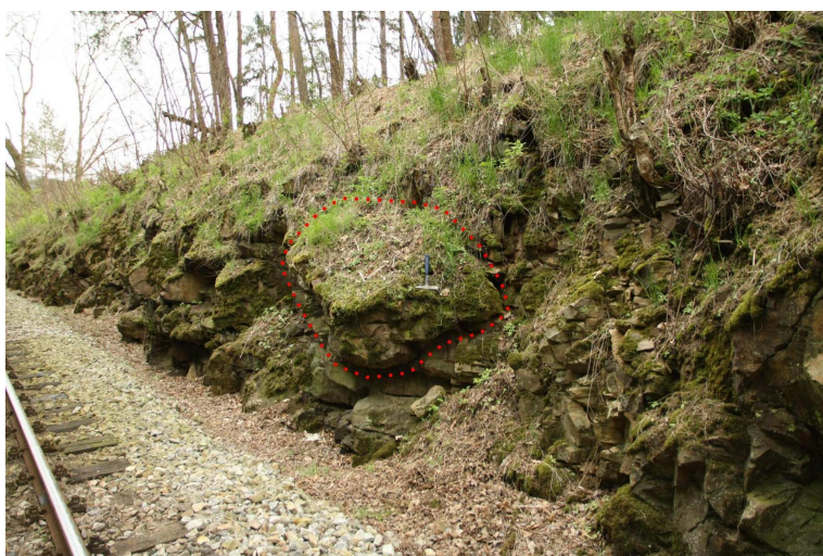
Foto 2-5 Solitérní skalní blok oddělený diskontinuitami od masivu. Jeho poloha je však stabilní.
