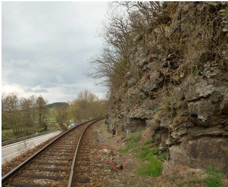
Foto 4-4 Skalní objekty o velikosti prvních \text{dm}^3 při okraji kolejiště na cca km 7,805.
