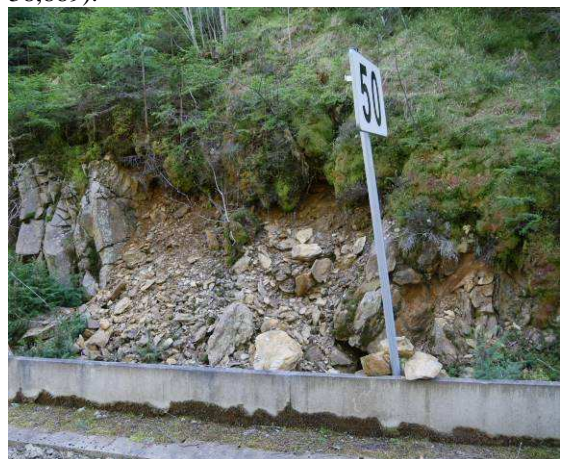
Foto 27-5 km cca 38,990 aktivní projev skalního řízení a zaplněný akumulační prostor za betonovou bariérou.
