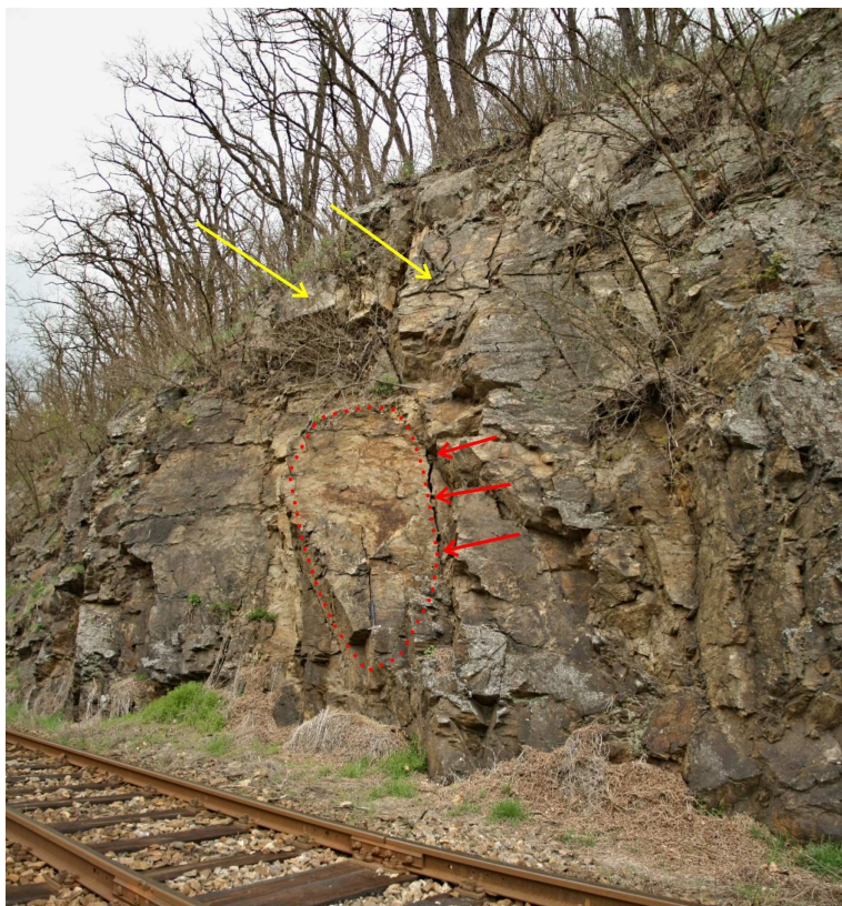
Foto 4-3 Pohled ze strany na situaci v cca km 7,826. Červený tečkovaný polygon zvýrazňuje plošný skalní objekt oddělený od masivu rozevřenou puklinou, jak ukazují červené šipky. Žluté šipky ukazují na zčásti sesypané skalní klíny, které jsou pod vlivem dezintegrace kořenovým systémem náletové vegetace (viz foto 4-2).
