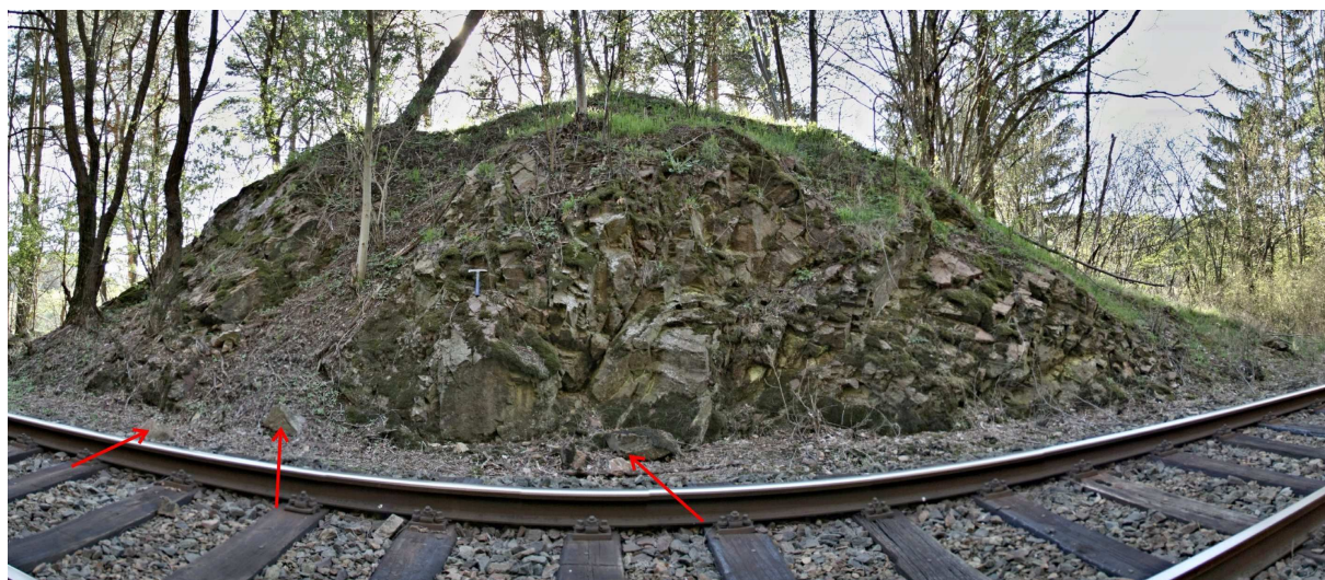
Foto 10-1 Panoramatický pohled na pravostranný zářez cca km 18,920–18,930. Šipky ukazují na osypané skalní objekty akumulující se u paty zářezu mimo ohrožený prostor kolejiště.
