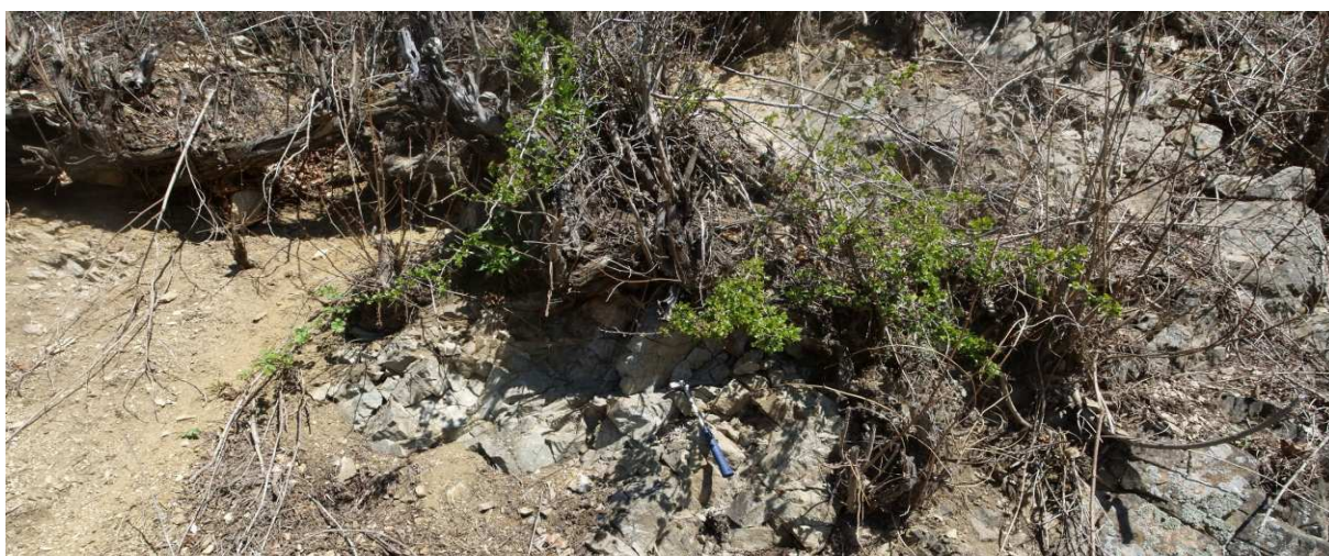
Foto 20-3 V puklinách se uchycuje náletová vegetace, která působí dezintegračně kořenovým systémem na horninový masiv. Zářez lze udržet stabilní běžnou údržbou průběžným odstraňováním náletových dřevin.
