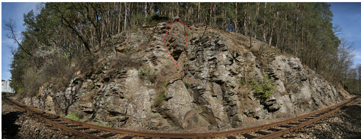
Foto 13-2 V části cca km 24,677–24,700 se nacházejí skalní výchozy vysoké asi 5 m se skalními klíny. Uprostřed obrázku výrazně červeným tečkovaným polygonem je příklad jednoho z nich.
