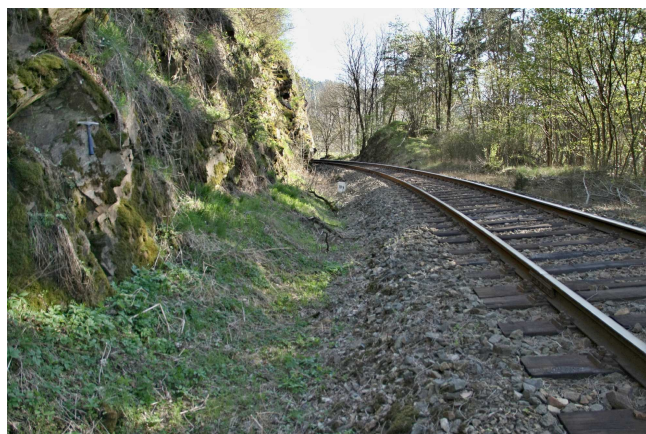
Foto 9-2 Prostorové poměry v nezajištěné části zářezu nižší jak 3 m. Pohybující se skalní objekt velikosti řádově \text{dm}^3 bude zastaven valem náspu železničního tělesa.
