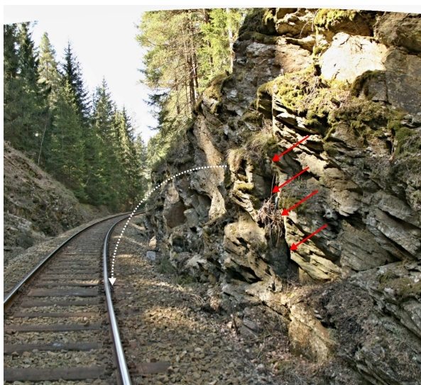
Foto 22-5 Pohled ve směru staničení v cca km 36,385. Šipky ukazují na puklinu oddělující blok od masivu. Bílá linie naznačuje trajektorii pohybu překlopením horní části, která by se s největší pravděpodobností transportovala do prostoru kolejiště.
