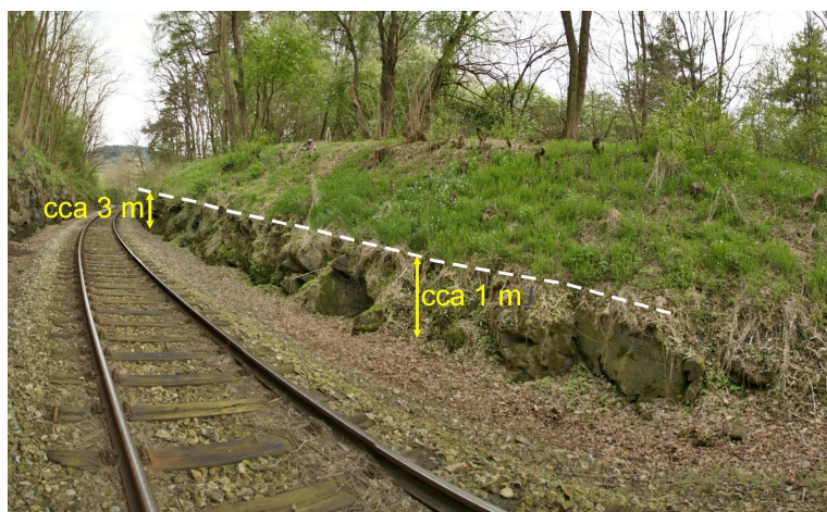
Foto 2-1 Začátek úseku v km 4,300 odkud se skalní zářez pozvolna zvedá z výšky cca 1 m do maxima okolo 3 m ve střední části.
