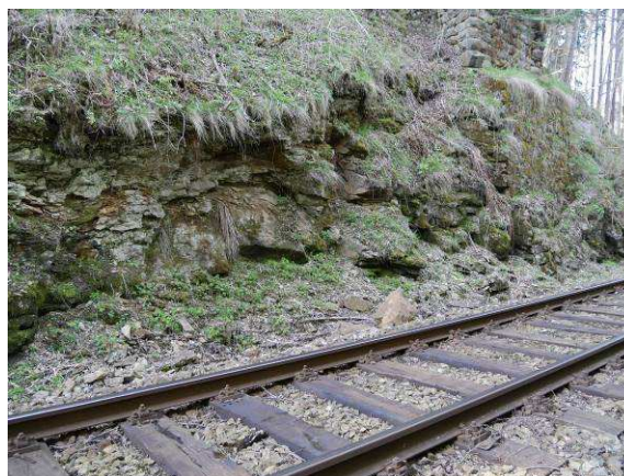
Foto 33-9 Pata skalního svahu výrazně zvětralá cca km 53,895.
