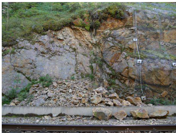
Foto 27-4 Zřícený skalní klín v km cca 38,930 akumulovaný za betonovými bariérami.
