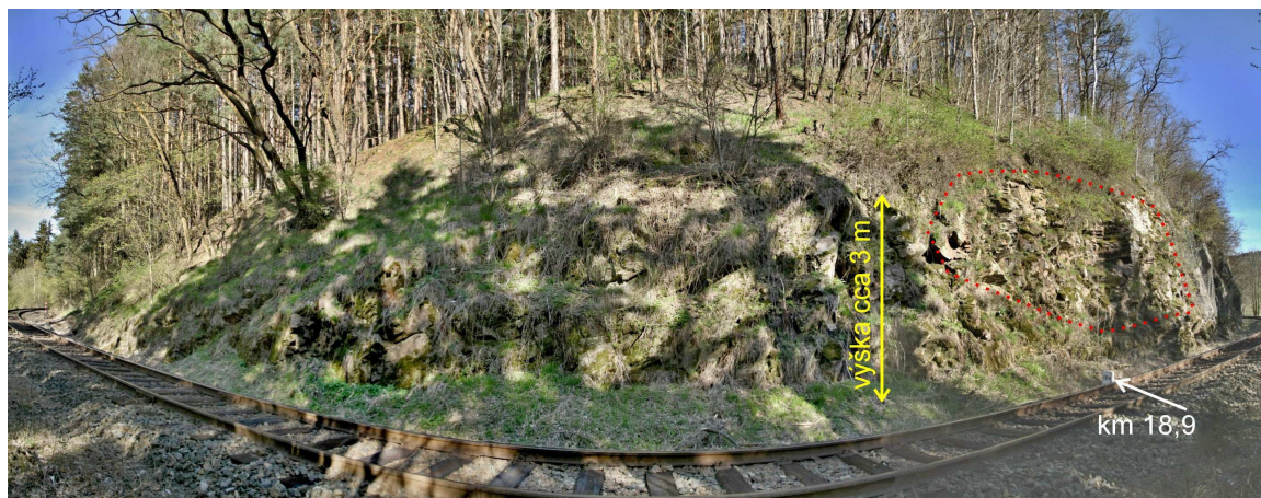
Foto 9-1 Nezajištěná část skalního zářezu, cca km 18,860–18,915. Od cca 18,883 výška zářezu ve směru staničení roste od 3 do cca 10 m. Červeně tečkovaný polygon naznačuje nezajištěnou část vyšší, než 3 m, kde riziková je především horní třetina zářezu.
