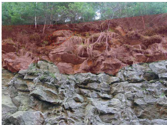
Foto 32-3 Část úseku v cca km 53,390 s červeně vyznačenou rizikovou horní partií zářezu a jedním potenciálně rizikovým blokem (ohraňčen červenou čárkovanou linií).
