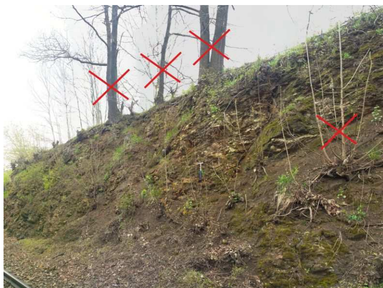
Foto 6-2 Zářez lze udržet stabilní běžnou údržbou průběžným odstraňováním náletových dřevin.
