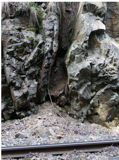
Foto 31-6 Cca km 53,390 tektonicky podmíněná zóna zvětrávání.
