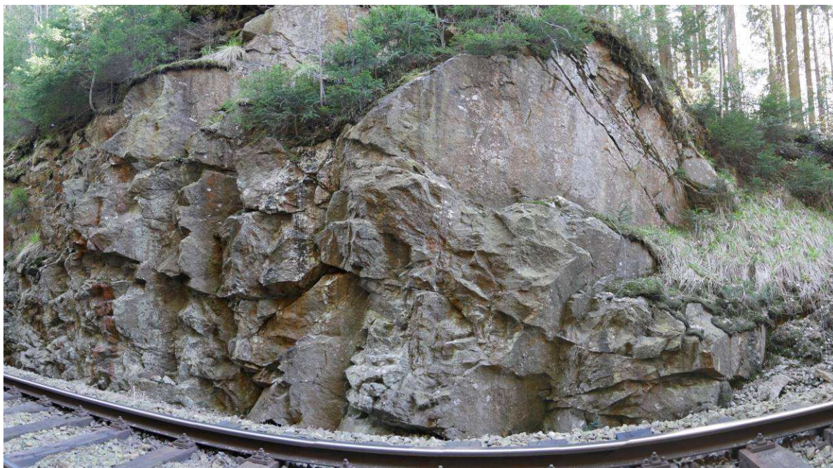
Foto 32-1 Část v cca km 53,300–53,385 relativně méně porušená křehkým porušením.
