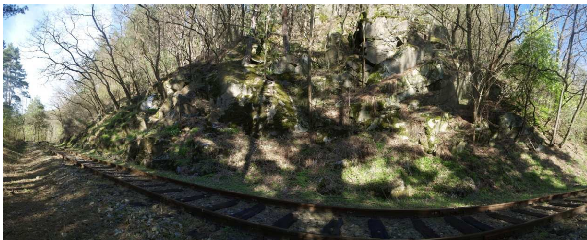
Foto 12-1 Celkový pohled na posuzovaný skalní svah. Dobře jsou vidět vyvinuté skalní převisy, ze kterých se průběžně uvolňují skalní bloky nejčastěji o velikosti do 1 \text{ m}^3 . Střední část skalního svahu je nejvíce náchylná k svahovému pohybu.
