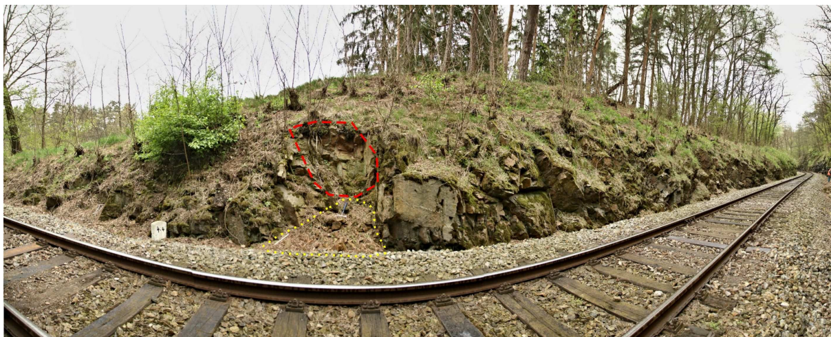
Foto 2-3 Poruchová zóna na konci úseku cca km 4,398, kde dochází k osypu z výšky asi 1,5 m. Sesypané úlomky nemají gravitační potenciál k transportu až do prostoru kolejiště.
