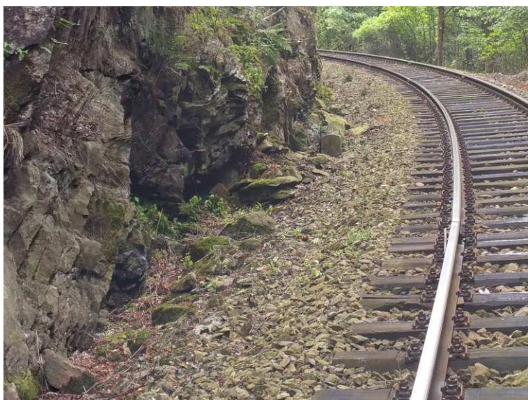
Foto 16-5 Další příklad relativně hojného výskytu menších skalních bloků s rozměry několika dm 3 při úpatí svahu.
