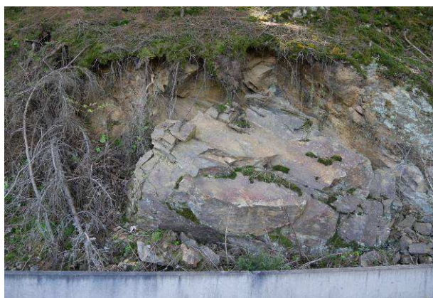
Foto 27-2 Dokumentovaný odvalený skalní blok o objemu cca 6 m 3 doporučený k odstranění (km cca 38,889).
