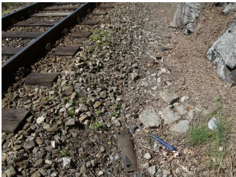
Foto 20-2 ČGS dokumentovala několik uvolněných menších skalních bloků s rozměry několika dm 3 .
