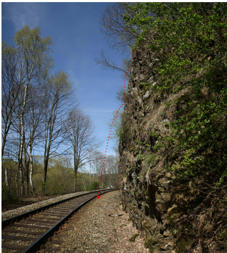
Foto 15-4 Pravděpodobná trajektorie sekundárního svahového pohybu odvalováním po povrchu svahu s možností dopadu do prostoru kolejiště.
