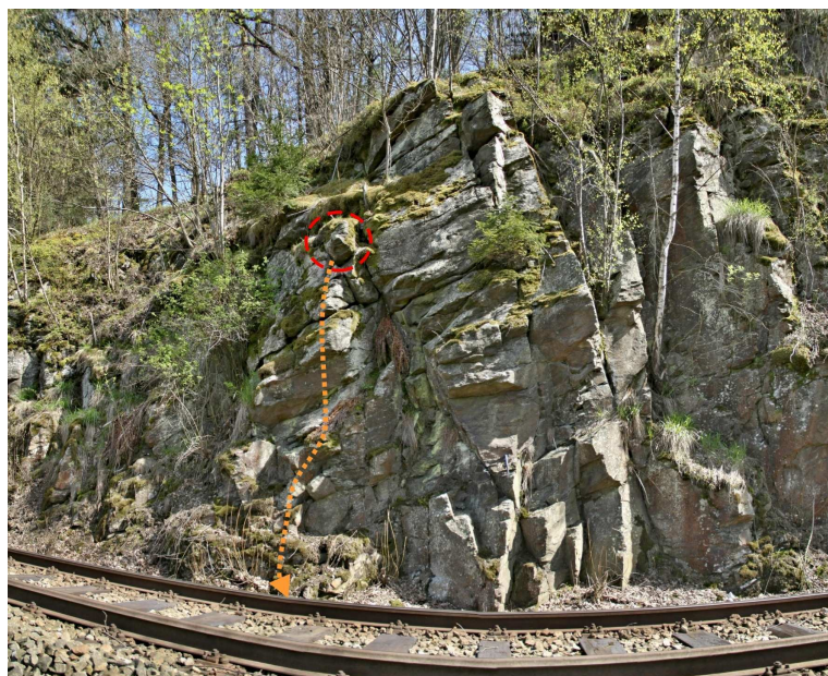
Foto 15-1 Část skalního zářezu okolo cca km 26,150–26,190. Ve skalní stěně se nachází solitérní skalní bloky jak zvyrazňuje červený kruh. Pravděpodobnou trajektorii pohybu naznačuje oranžová tečkovaná linie, kde pohyb se zastaví vedle kolejiště.
