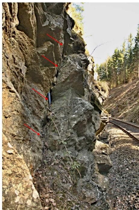
Foto 22-4 Šipky ukazují na puklinu oddělující blok od masivu.
