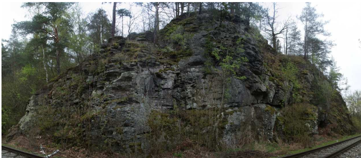
Foto 8-3 Celkový pohled na posuzovaný úsek. Zřetelně je vidět kvádřovitá odlučnost skalních bloků. Při patě svahu se nacházejí nepříliš mocné osypové kužely, ze kterých vyrůstají náletové dřeviny. Skalní svah je lokálně porostlý náletovými dřevinami.
