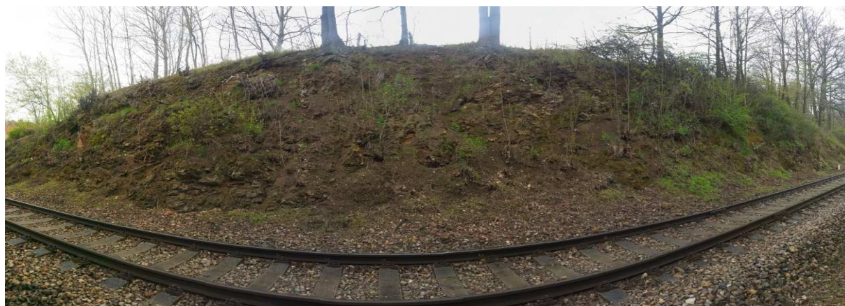
Foto 6-1 Panoramatický pohled na posuzovaný zářez. Zřetelně lze vidět, že skalní svah je již z velké části pokryt vrstvou humusu a různými travinami.
