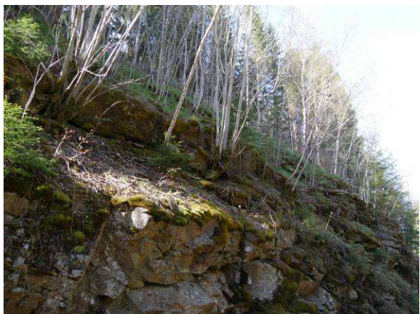
Foto 33-8 Vyšší partie skalní stěny, výrazně pokryta náletovými dřevinami. Rizikově ukloněné plochy odlučnosti směrem po svahu.
