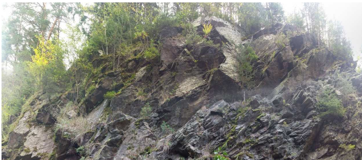
Foto 16-6 Zejména v horní části posuzovaného skalního svahu se vyskytují četné skalní převisy.
