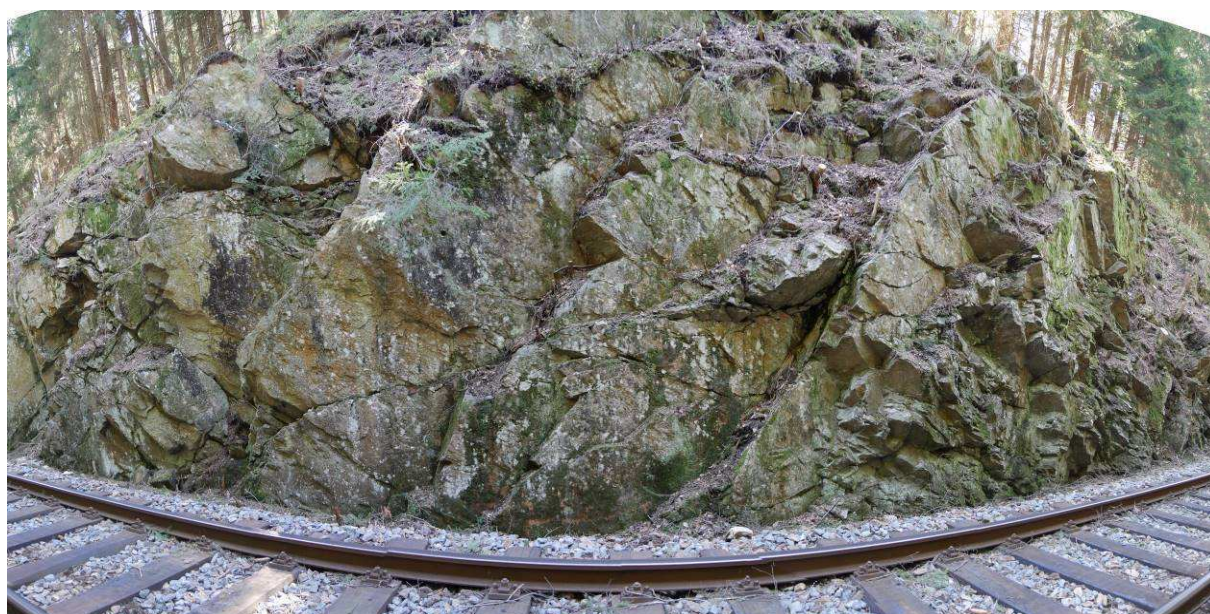
Foto 29-2 Panoramatický pohled na úsek zářezu relativně méně rozpukaného v porovnání s porušenějšími částmi.
