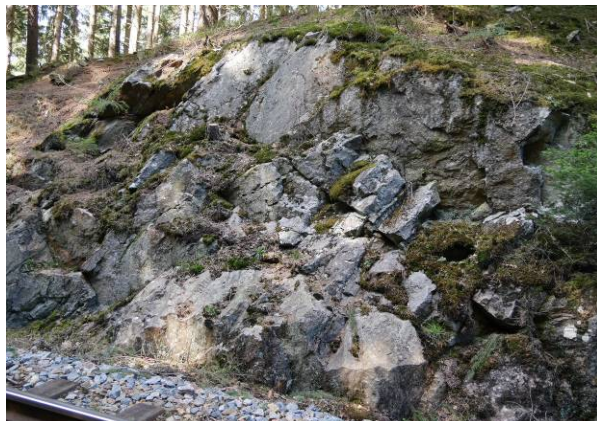
Foto 30-2 Poměrně kompaktní skalní stěna, u níž postačí k udržení nízkého rizika, pravidelná údržba
