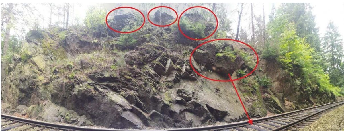
Foto 17-3 Celkový pohled na posuzovaný zářez část 2. Ve stěně jsou nesouvisle uchyceny náletové dřeviny, které masiv rozrušují. Dále je patrný výrazný puklinový systém, uklánějící se směrem po svahu. V kombinaci s dalšími puklinovými systémy jsou v horních partiích svahu vyvinuty četné převisy (červené elipsy). V případě uvolnění převisu může dojít k zahrazení tratě.
