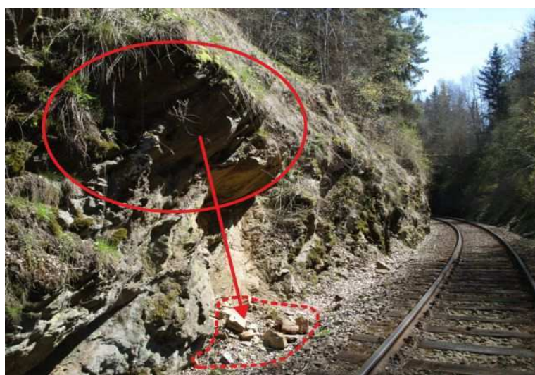
Foto 24-1 Poměrně výrazný skalní převis (červená elipsa) nacházející se v km 36,700, na němž dochází k aktivnímu projevu svahového pohybu typu opadávání (červená šipka a čárkovaný polygon).
