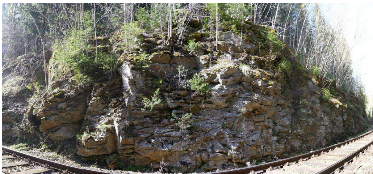
Foto 33-1 Část km 53,760–53,900 velice porušená křehkými diskontinuitami a pokrytá náletovými dřevinami
