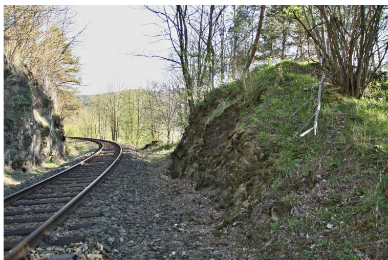
Foto 10-2 Pohled ze strany na odstup tělesa železnice od paty zářezu, kde se akumulují sesypané skalní objekty.
