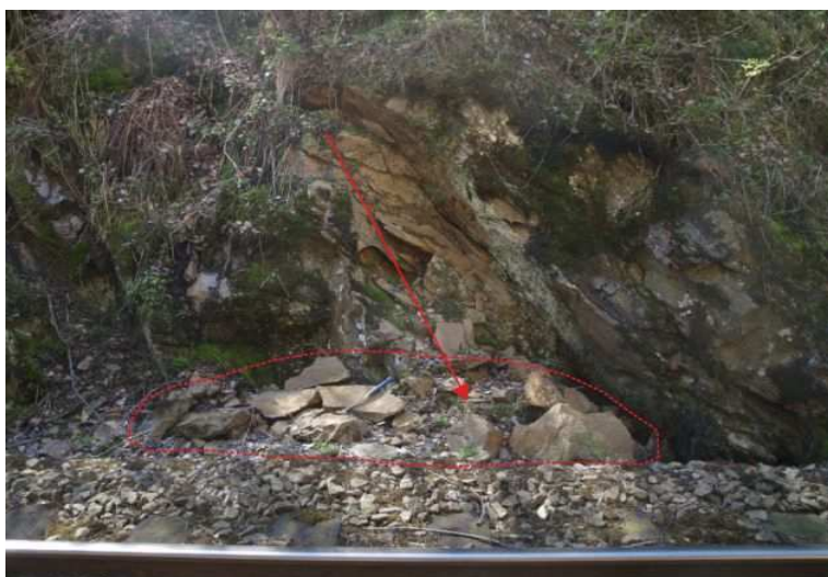
Foto 23-3 Příklad aktivních projevů svahového pohybu odvalování sklouznutím. Šipka znázorňuje přibližnou trajektorii pohybu po předurčené ploše. Tečkovaný polygon ohraničuje ospyvý kužel.
