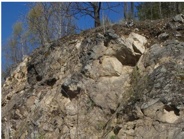
Foto 19-1 Ve skalní stěně se lokálně vyskytují drobné převisy a volné bloky o velikosti zpravidla několik dm 3 .
